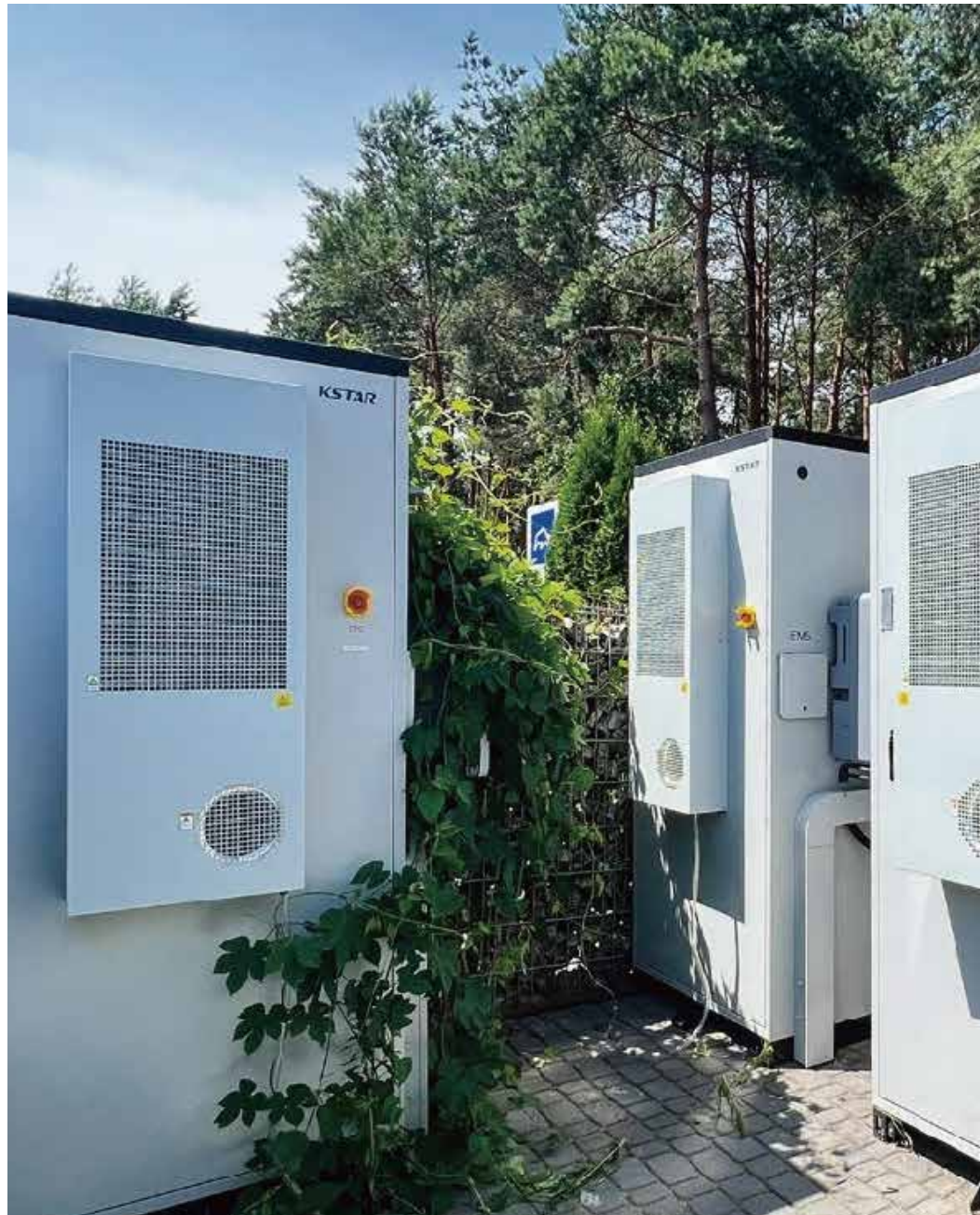
06 Lokalizacja: Radawa, Polska Pojemność: 150kW, 300kWh
