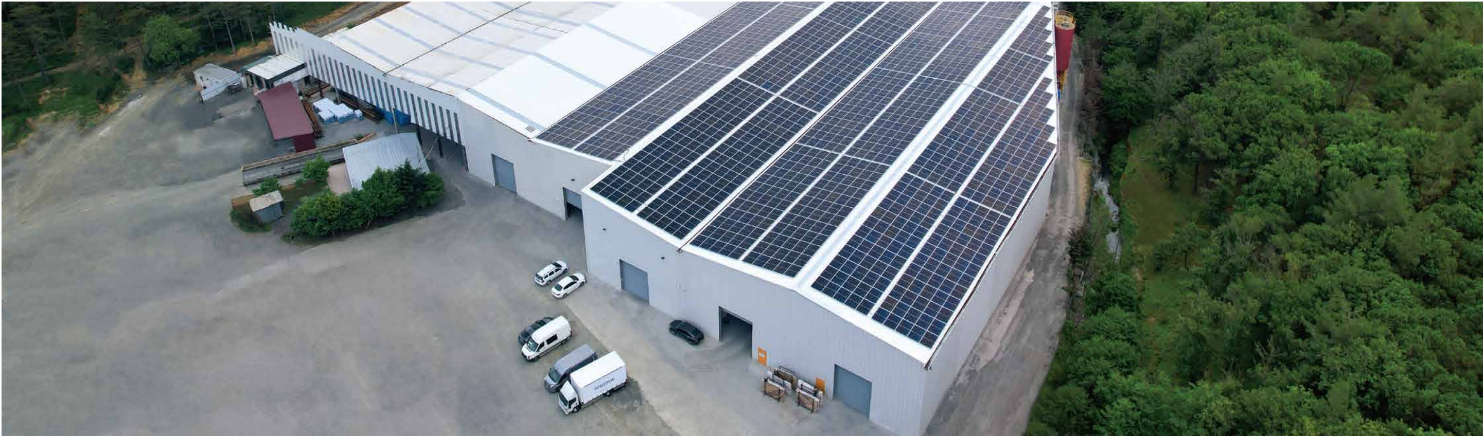
04 Redukcja kosztów energii dla fabryki wody mineralnej Turcja, 900kW KSG-120CL-M0
